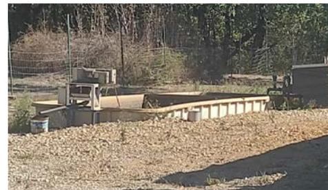
SYSTEME D'ARROSAGE DES FERRAILLES AVEC LA RECIRCULATION DES EAUX PLUVIALES
